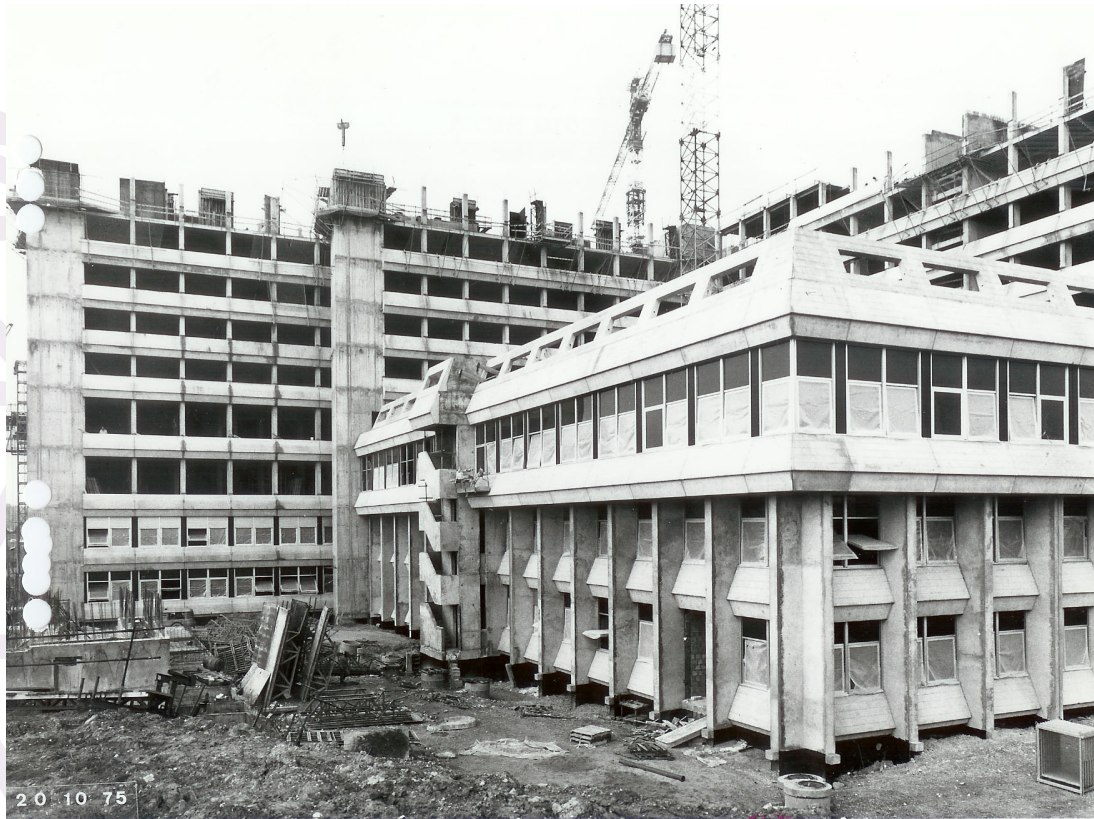
Construction de l'hôpital Jean, CHU de Poitiers
